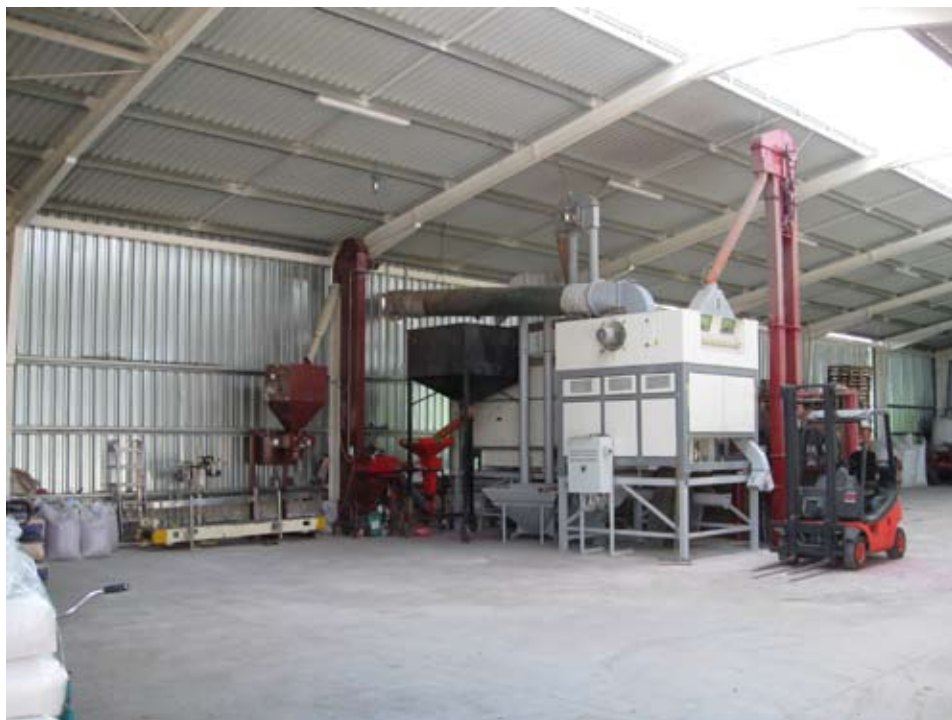
Wiktorowo – hala magazynowa - fot. K. Kalek.
